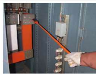
▲高壓電檢修安全教育訓練
