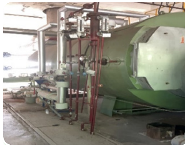
「資源交換平台」中上架設備：臥型爐筒煙管式鍋爐
