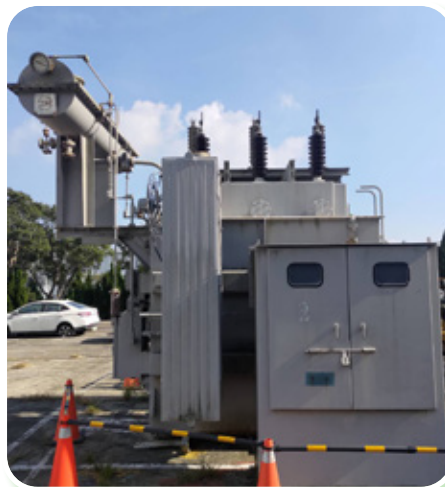
「資源交換平台」中上架設備：油性變壓器
